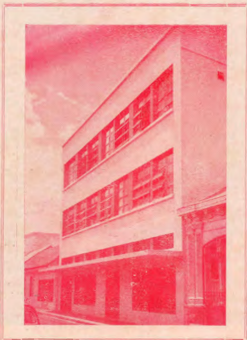
Nuevo edificio para sus Oficina Generales y Central de Teléfonos
